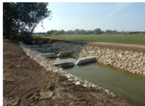
L'aménagement de la prise d'eau de la Morte est achevé.
