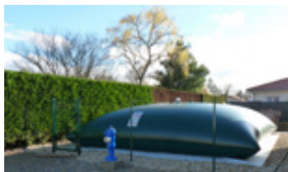
Le chantier pour la création de la réserve incendie de Chassagne centre arrive à son terme
